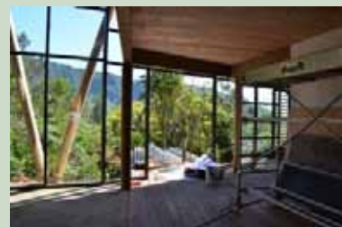
Chantier de la Maison du parc national à la Plaine des Palmistes © Parc national de La Réunion - Isabelle de Lavergne
